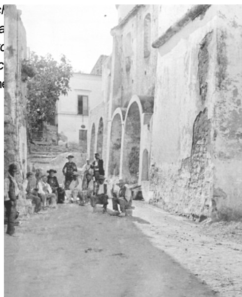
Figura 5 - foto fine 800, sulla sinistra la chiesa di S.Maria
