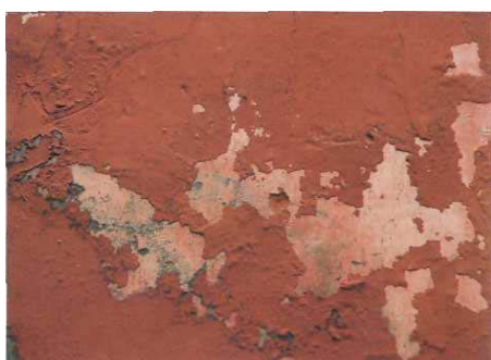
Figura 1 - S.Agata, esempio di pitturazione polimerica stesa su una precedente tinta tradizionale.
